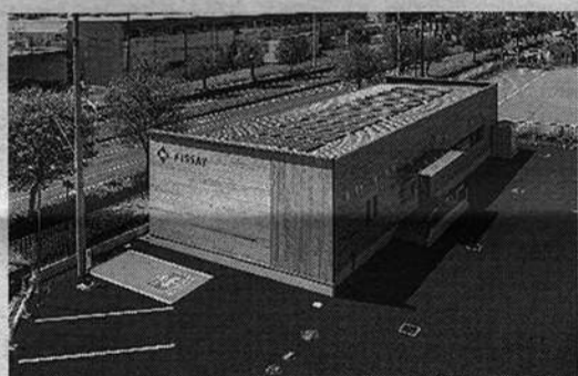
群馬富岡オフィスの外観
